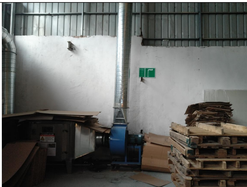
集气罩+活性炭净化器+排气筒
